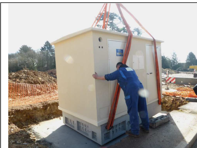
Installation cabine transfo rue de Boulaines
