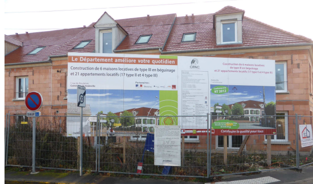
Constructions en cours angle rue Jean Jaurès - rue de Boulines
